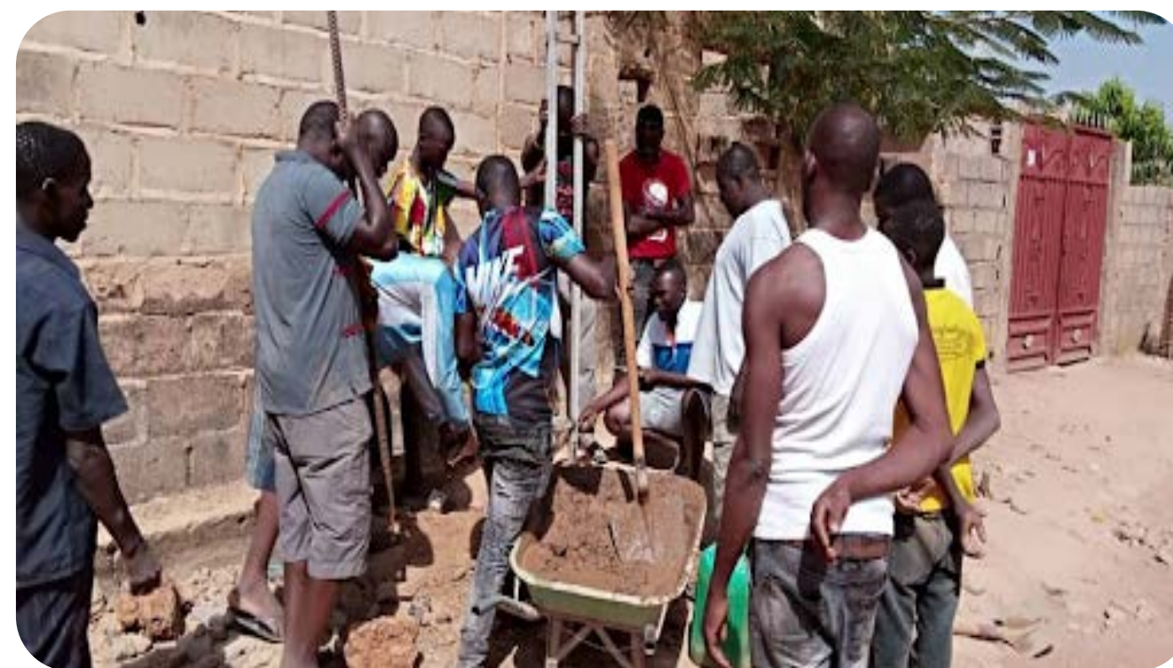
@ Photo YS: chantier participatif dans le quartier non loti de Boassa
