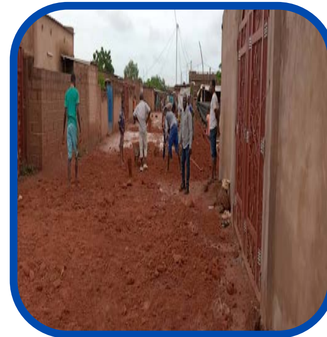
@ Photo YS : Aménagement concerté de voirie à Boassa
